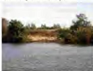
Размыв насыпной дамбы в канале
