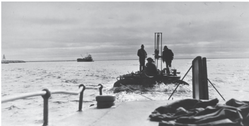
Буксировка понтона с буровой установкой
