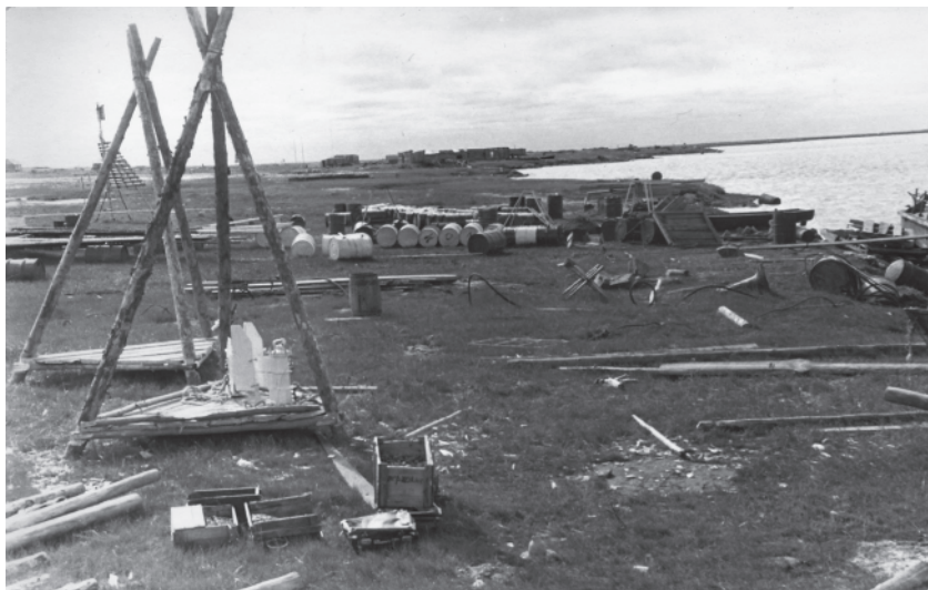
Треноги для установки буквопечатающих вертушек
